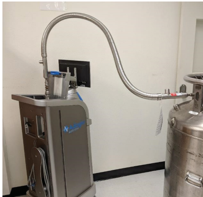
Figure 25 – Connexions réalisées pour le remplissage
